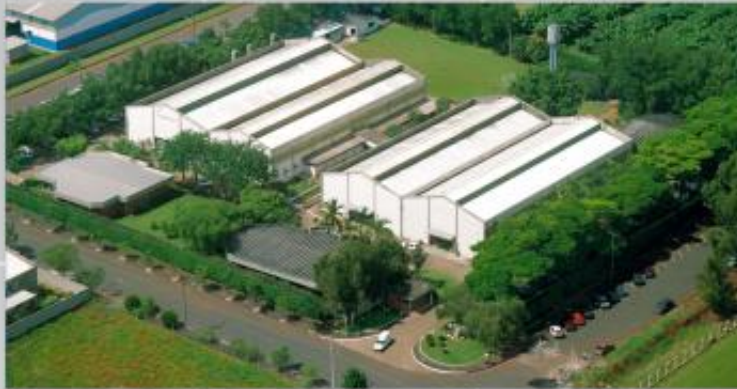
Instalações da Metroval - Nova Odessa - SP
