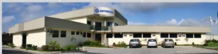
Instalações da Metroval - Macaé - RJ
