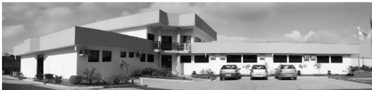
Instalações da Metroval - Macaé - RJ
