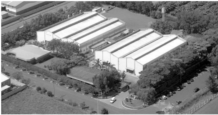
Instalações da Metroval - Nova Odessa - SP
